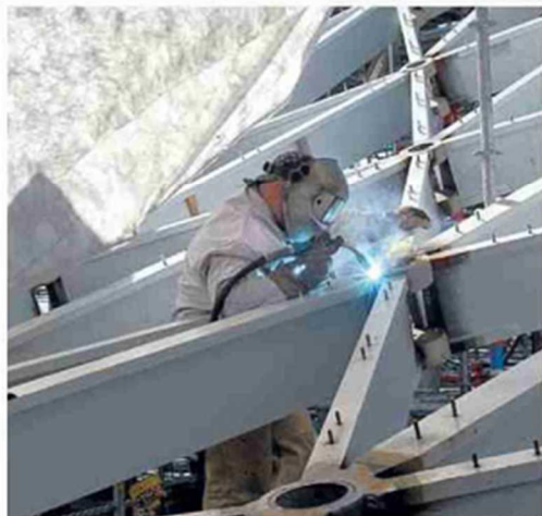
Secondo Pizzarotti in Italia è ripartito il 70% dei cantieri
