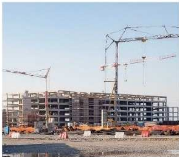
CENTRO COMMERCIALE Un'immagine del cantiere per la costruzione del nuovo mall vicino alle Fiere e, in alto a sinistra, il presidente nazionale dell'Ance Gabriele Buia.
