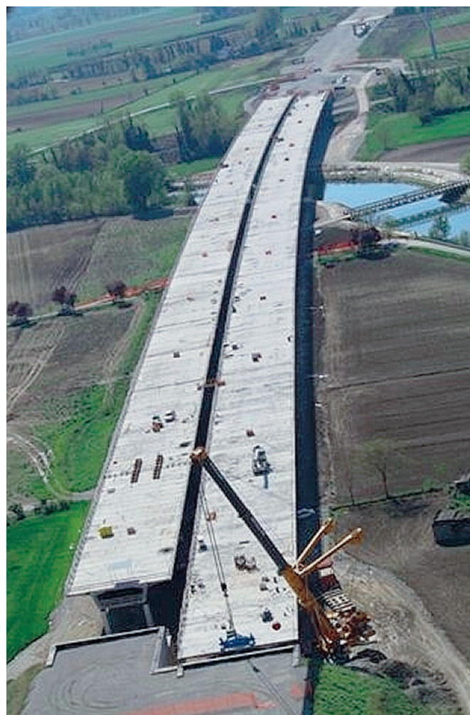
Brebemi Vista aerea del viadotto sull'Adda/canale Muzza.
