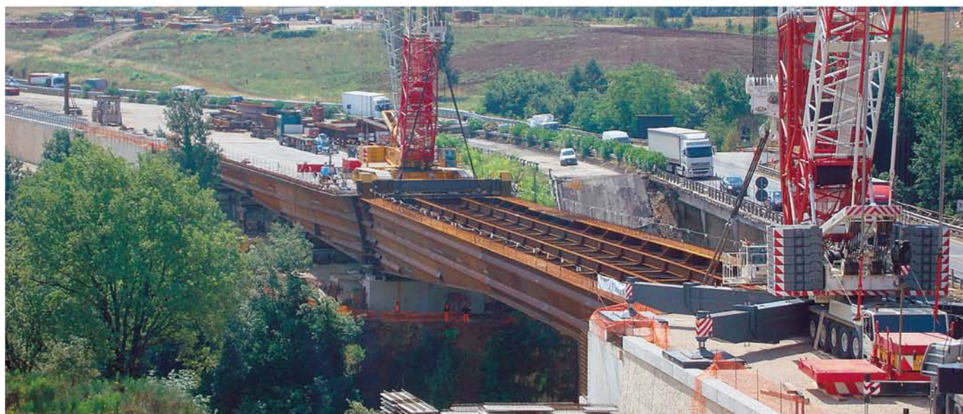
Salerno-Reggio Calabria | I lavori della Pizzarotti sul viadotto Molino nel corso dei lavori nelle scorse settimane.
