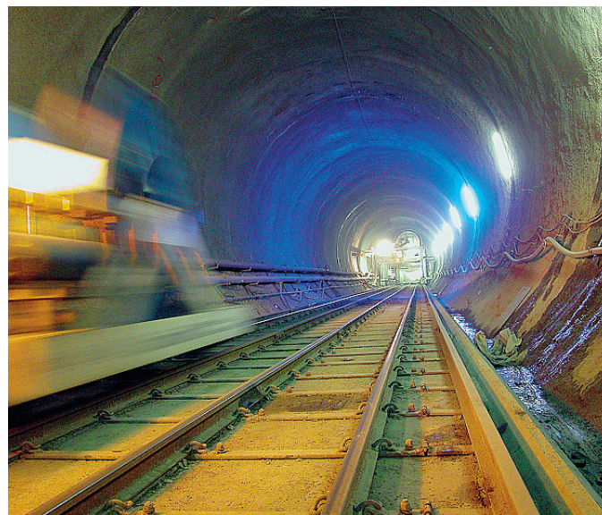
Pizzarotti Un tratto dei lavori realizzati per Alptransit.
