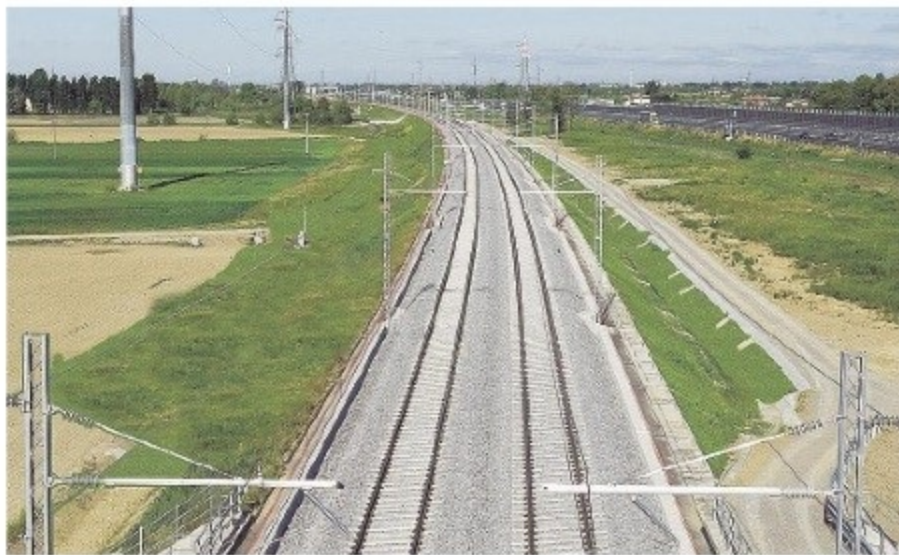
Linea ferroviaria dell'Alta velocità Treviglio-Brescia Un'immagine della nuova tratta.
